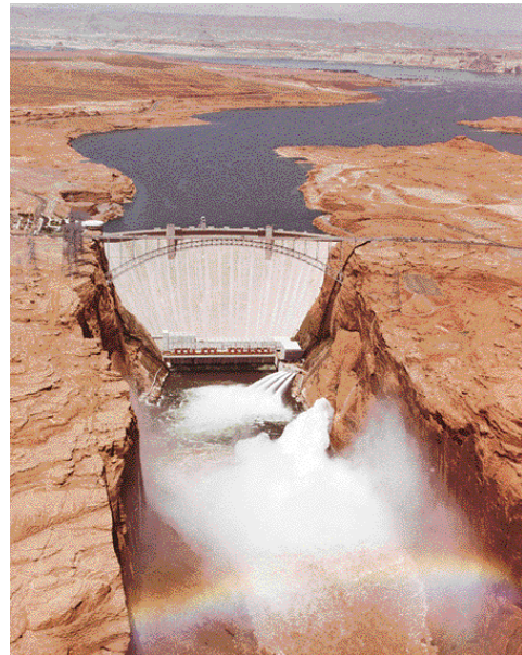
Dans cette vue aérienne, la "Glen Canyon Dam" arrêtant les eaux de la Colorado River paraît être un petit barrage. Le mur est en fait long de 480m et haut de 220m. Au maximum de sa capacité, le lac Powell ainsi créé peut atteindre 300km de long et 40km de largeur, soit une surface de 65.300ha, et emmagasiner jusqu'à 30km 3 d'eau. La longueur de son rivage est estimée à 3.000km environ.
